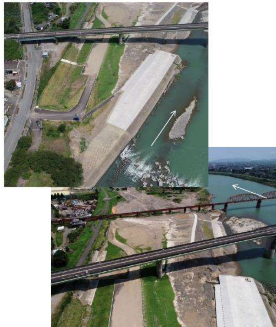
●洪水後の広場被災状況
