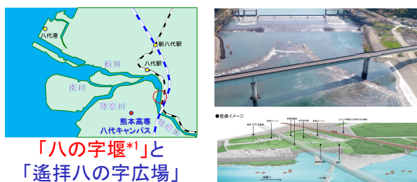
図1) 八の字堰と遙拝八の字広場
